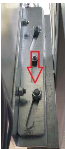
Compensación de ángulo en el soporte de montaje inferior
