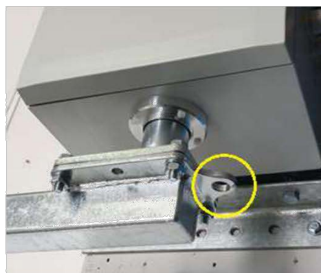
Conexión a tierra mediante tornillo M16
